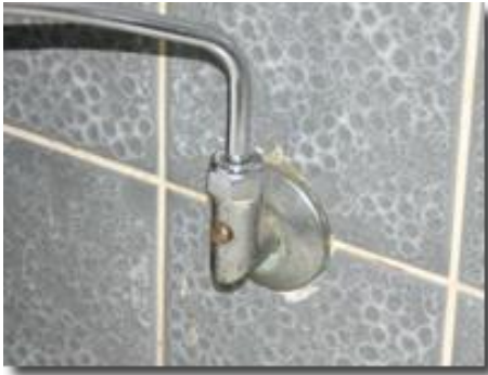
Fig 2. Utæt ballofix ventil
