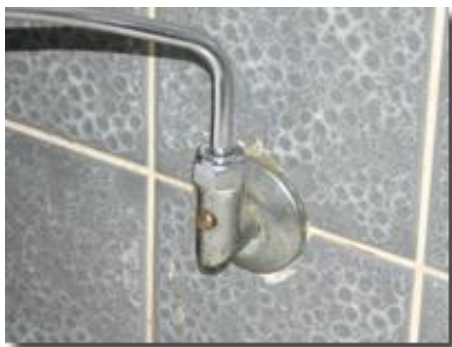
Fig 2. Utæt ballofix ventil
